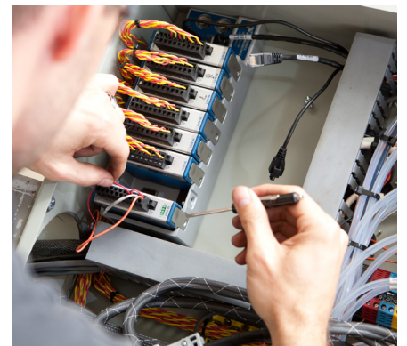
엔진 테스트 셀의 일부로 사용되는 산업용 인클로저에 있는 CompactDAQ
